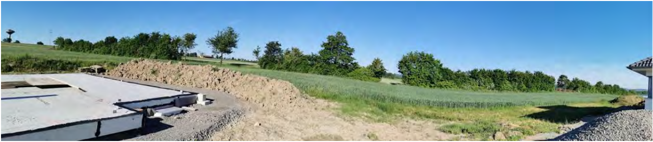
Abb. 7: Blick in das Plangebiet aus südöstlicher Richtung mit einer grasreichen Ruderalfläche und Erdaushüben der Josef-Störzer-Straße im Vordergrund. Im Hintergrund ist das Weizenfeld mit der angrenzenden Baumhecke zu erkennen. (Aufnahme vom 15.06.2021)
